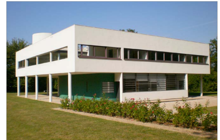
2. Villa Savoye (1928–1931): kulturní funkcionalistická vila od Le Corbusiera. Má typické znaky požadované Le Corbusérem - piloty vynášející dům, prostor pro střešní zahradu, skeletovou konstrukci, pásová okna, volné průčelí.
