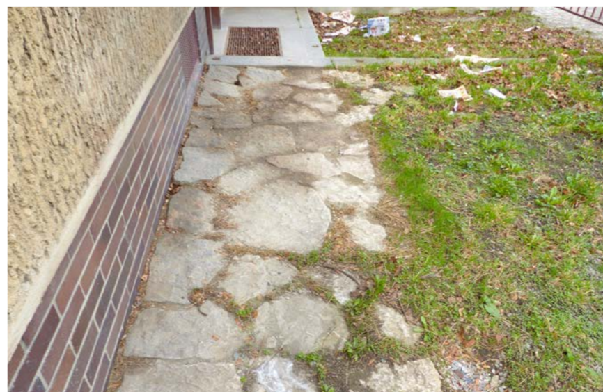
50. Zpevněná plocha z kamenných šlapáků
