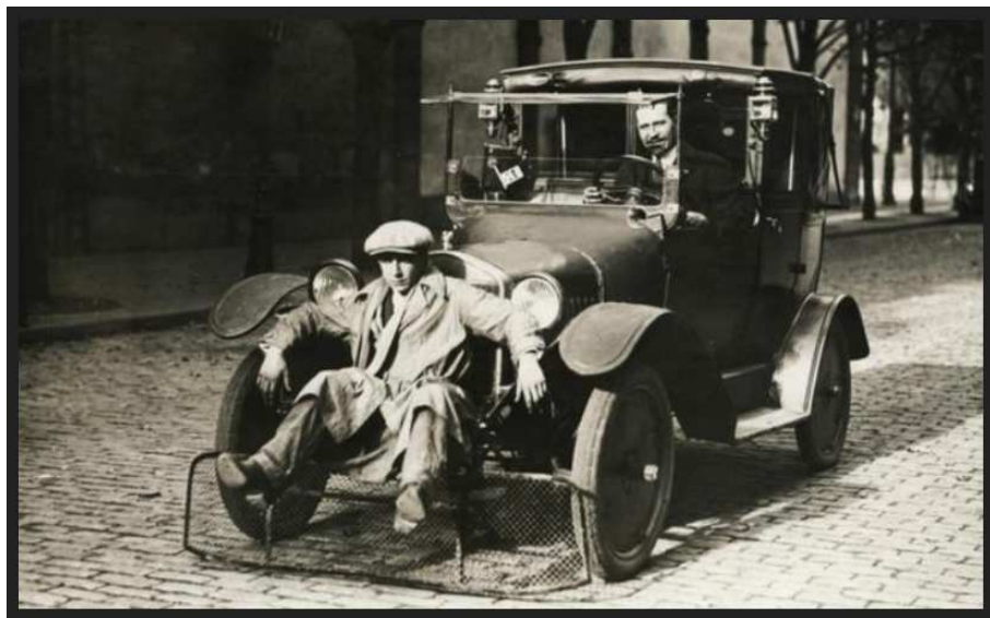
Obr. 1 John O 'Leray již v roce 1908 navrhl jednoduché zařízení se sítí pro ochranu chodců (1)
