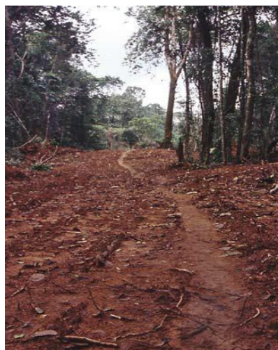
Obrázek 7: Stavba silnice západně od lesní rezervace Mone River, která umožní lepší přístup k zalesněným oblastem spojujících území Mone a Takamanda
