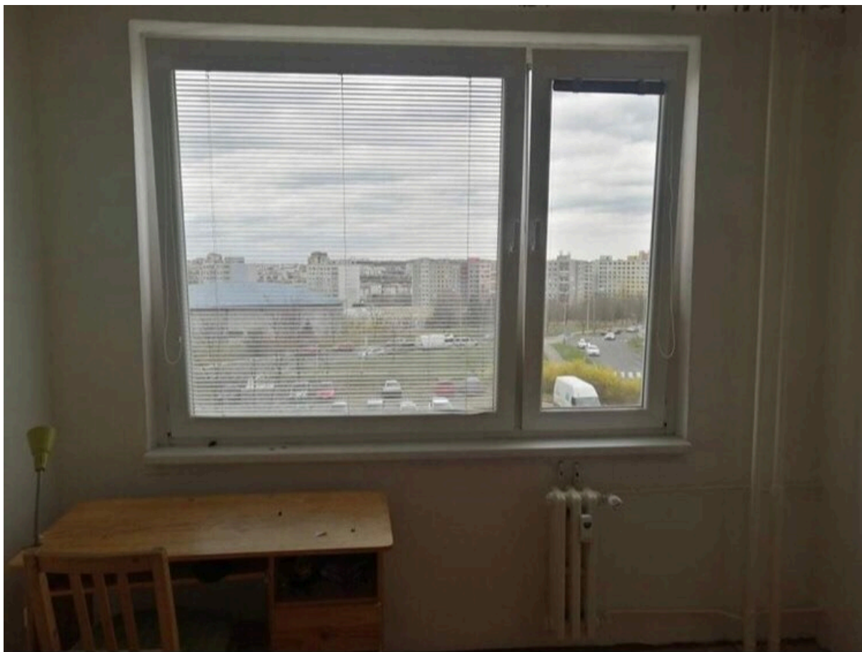
Obr. Foto místnosti oken č. 2
