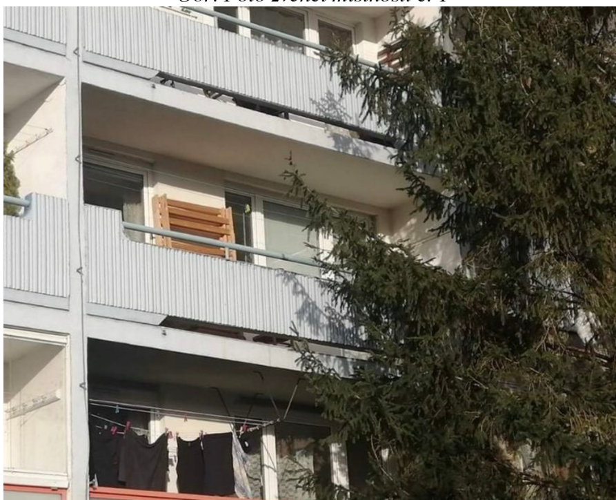
Obr. Foto zvenčí místnosti č. 1
