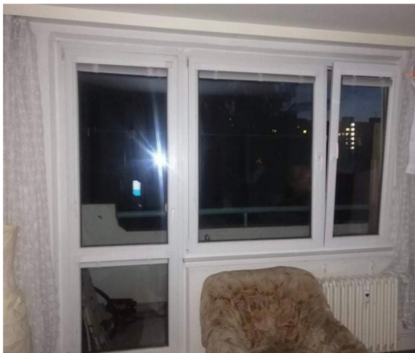
Obr. Foto místnosti oken č. 1
