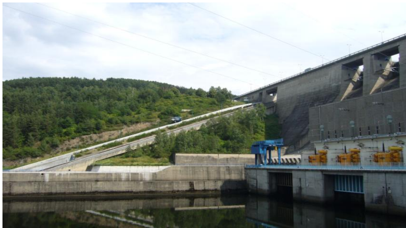
Obr. 16 Přehradní hráz Orlík – v pozadí lodní výtah
