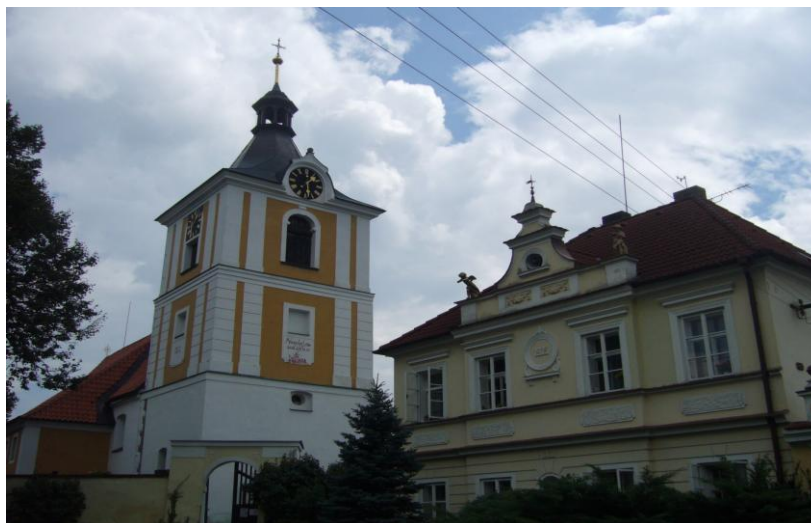
Obr. 14 Kostel s farou v Kostelci nad Vltavou
