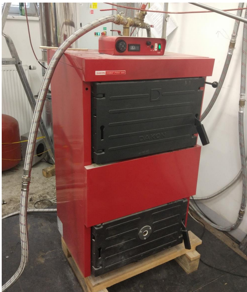
Obr. 3-1 Zplyňovací kotel Dakon Damat Pyro 20 G.
