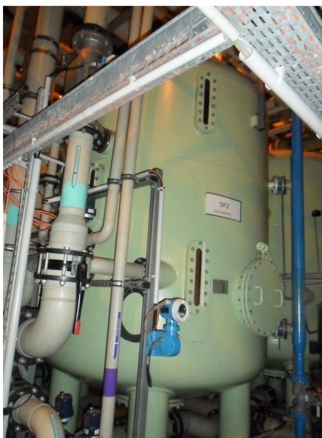
Příloha č. 6 Směsné filtry (foto Krausová)
