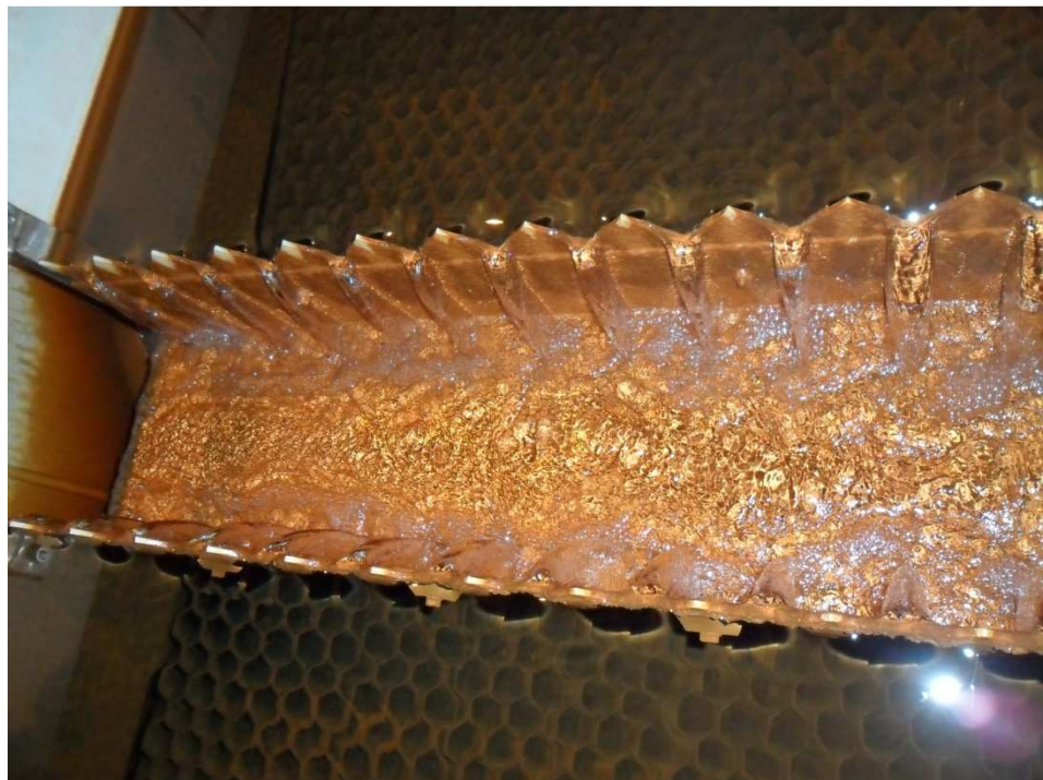
Příloha č. 4 Lamely čičiče Actiflo® (foto Krausová)
