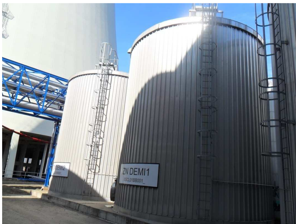
Příloha č. 7 Dvě zásobní nádrže DEMI vody před směsnými filtry (foto Krausová)
