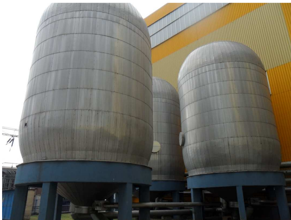
Příloha č. 8 Tři zásobní nádrže DEMI vody za směsnými filtry a upraveného vratného topného kondenzátu (foto Krausová)
