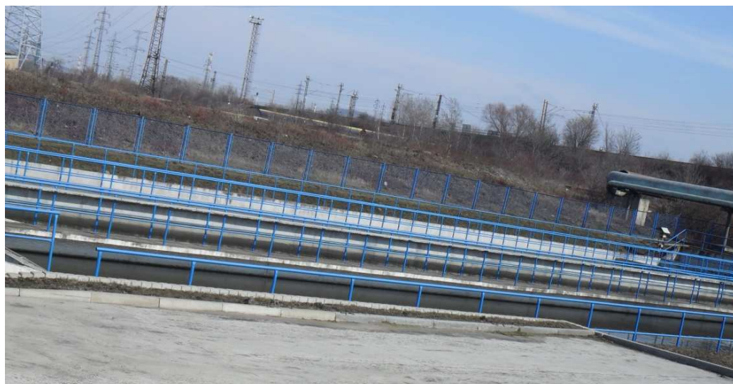
Příloha č. 10 Likvidace odpadních vod – Usazovací nádrže před výpustí do recipientu řeky Bíliny (foto Krausová)
