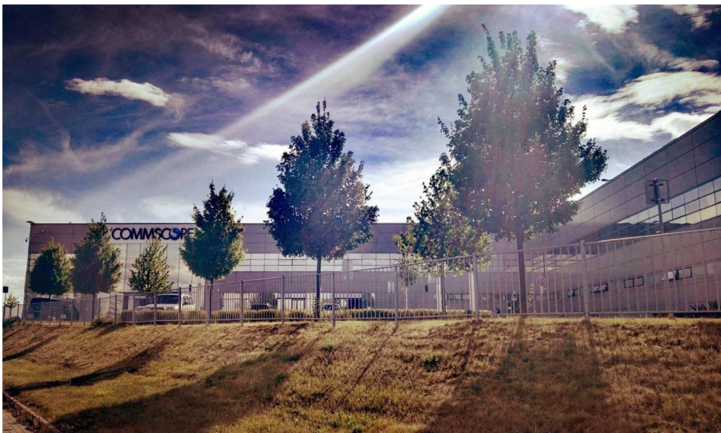
Obr. 3.1 Závod v Brno-Tuřany [22]
