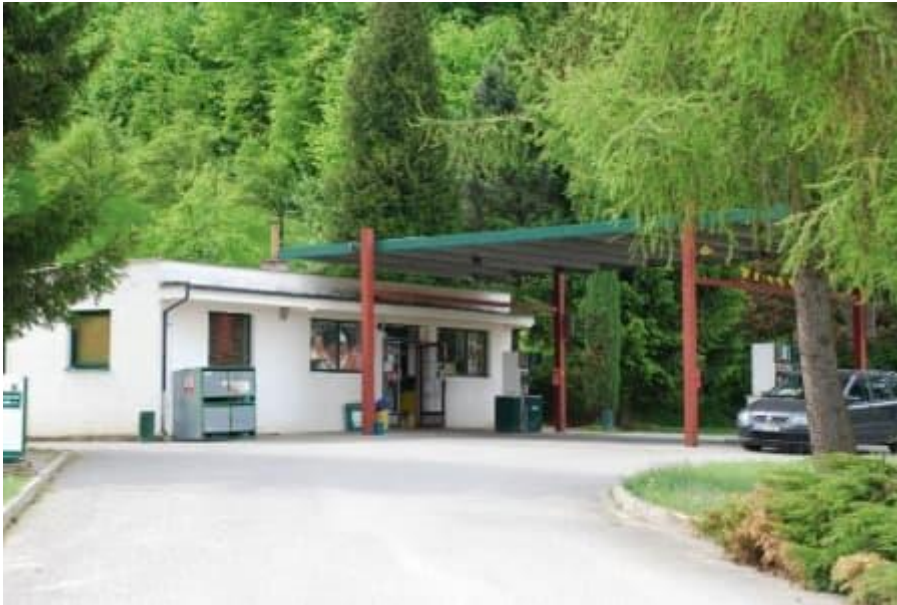
Obr. 5 Čerpací stanice Ebu
