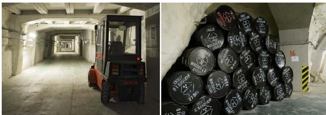
Obr. 2 Úložiště Richard II. U Litoměřic, zdroj: Centrum experimentální geotechniky, 2014
