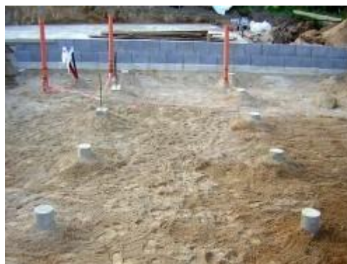
Obr 17 Založení na pilotách (Brotánek, 2016)
