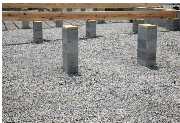
Obr 2 Základy dřevostavba-crawl space (Shutterstock, 2016)
