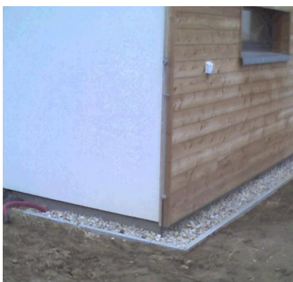
Obr 38 Snímek zatepleného soklu
