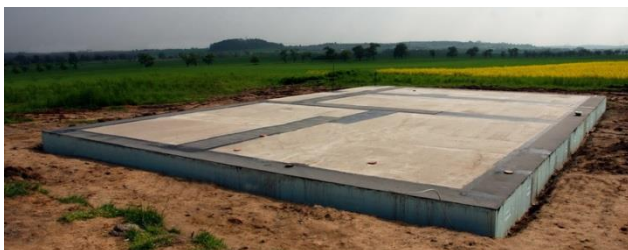
Obr 1 Základové pasy RD (Základy-RD, 2016)
