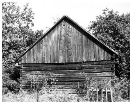
Obrázek č.14: Dřevěná konstrukce, zdroj: muzeum-pribram.cz
