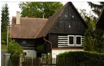
Obrázek č.40 : dům č.p. 352, zdroj: Autor 2010
