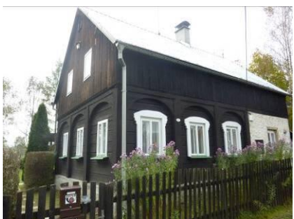
Obrázek č.50 : dům č.p. 497, zdroj: Autor 2010
