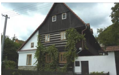
Obrázek č.38 : dům č.p. 354, zdroj: Autor 2010
