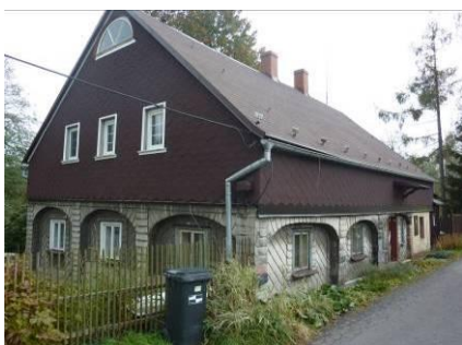
Obrázek č.46 : dům č.p. 216, zdroj: Autor 2010
