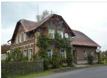
Obrázek č.47: dům č.p. 502, zdroj: Autor 2010
