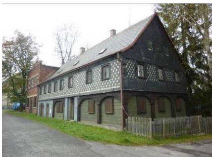
Obrázek č.45 : dům č.p. 42, zdroj: Autor 2010
