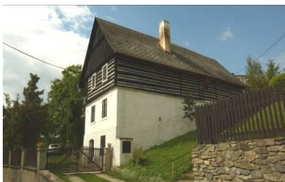
Obrázek č.39 : dům č.p. 394, zdroj: Autor 2010
