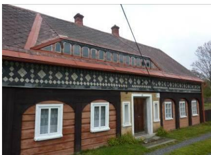
Obrázek č.48 : dům č.p. 324, zdroj: Autor 2010
