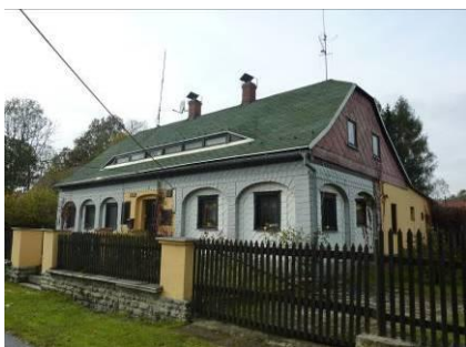
Obrázek č.49 : dům č.p. 424, zdroj: Autor 2010
