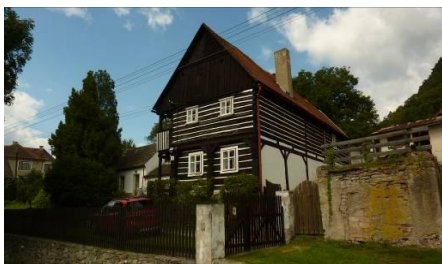
obrázek č.36 : dům č.p.359, zdroj: Autor 2010
