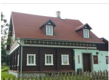
Obrázek č.51 : dům č.p. 223, zdroj: Autor 2010
