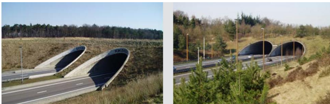
Obrázek č. 12 Nadchody - tunely (Hlaváč & Anděl, 2008)
