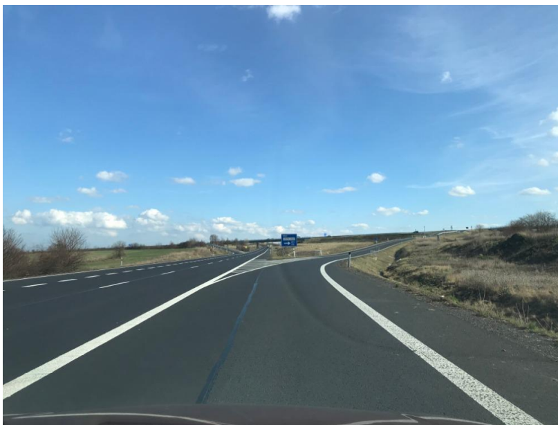
Obrázek č. 19 Rizikové místo - silnice I. třídy, č. 7, 49,2. km, Louny - směr Zeměchy
