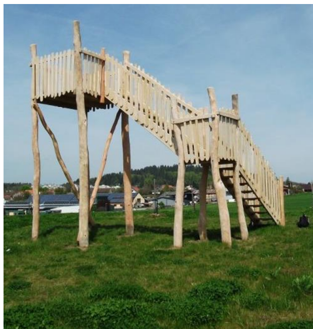
Obrázek 7: Rozhledna Hradiště v Písku (Rozhledna Hradiště, 2023)
