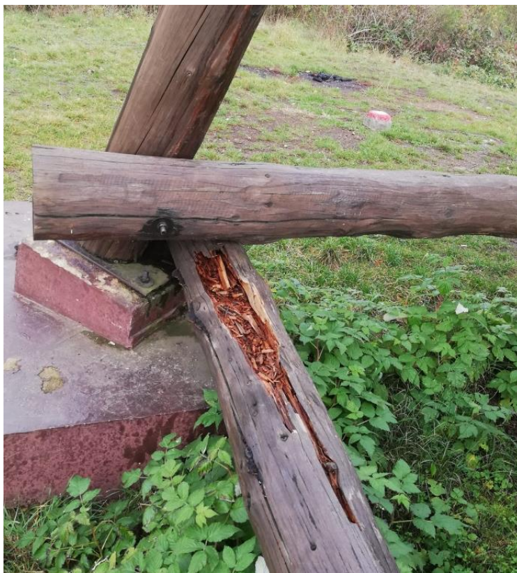
Obrázek 44: Hniloba na prvku rozhledny (Zdroj: Autor práce)
