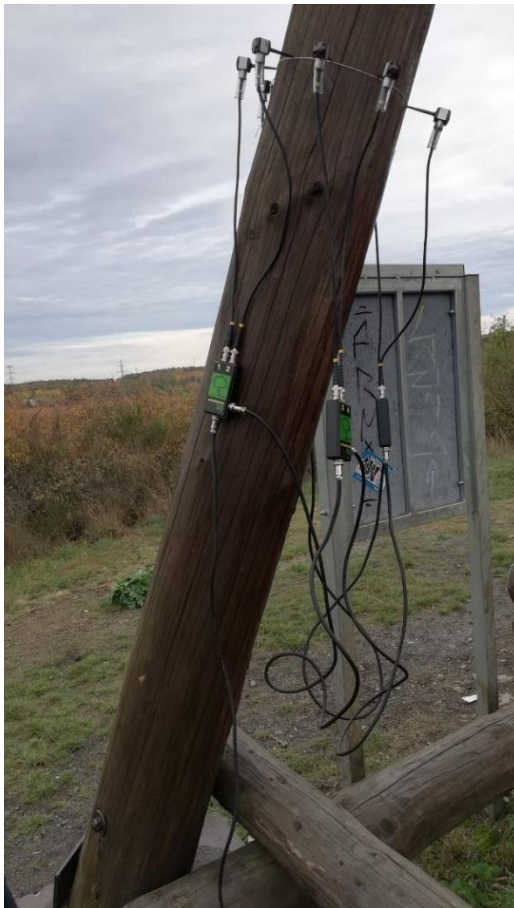
Obrázek 50: Kontrolovaný severovýchodní trám (Zdroj: Autor práce)
