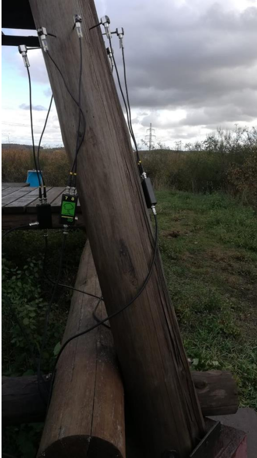
Obrázek 55: Kontrolovaný jihozápadní trám (Zdroj: Autor práce)
