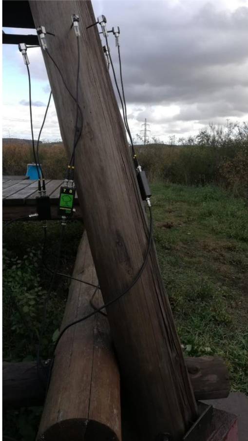
Obrázek 55: Kontrolovaný jihozápadní trám (Zdroj: Autor práce)
