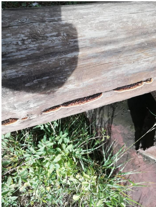
Obrázek 42: Dřevokazné houby na prvku rozhledny (Zdroj: Autor práce)
