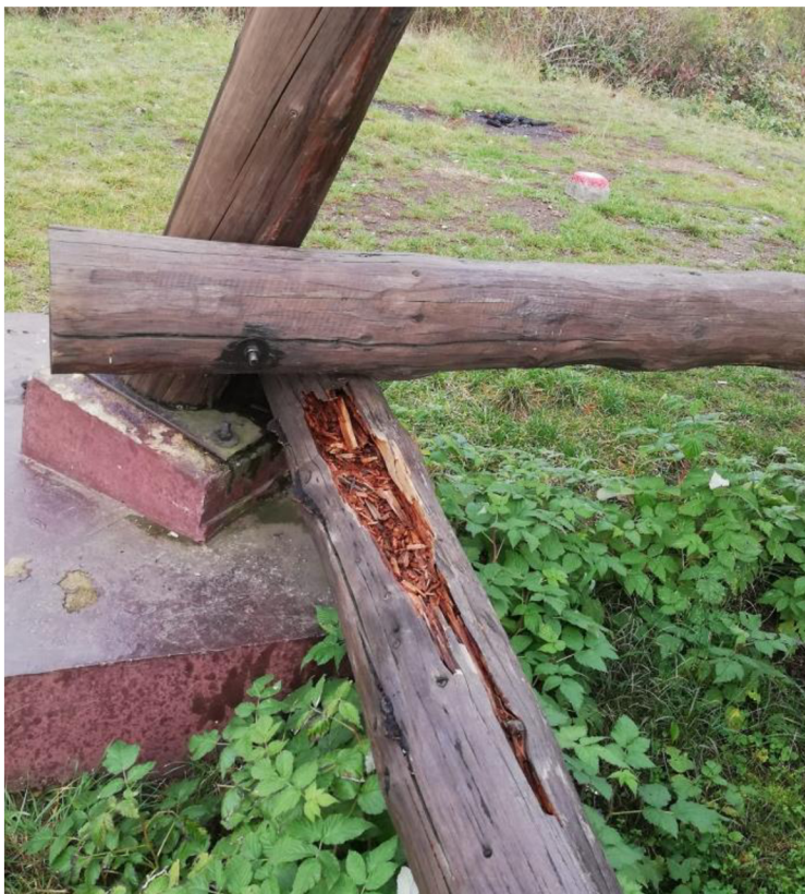
Obrázek 44: Hniloba na prvku rozhledny (Zdroj: Autor práce)
