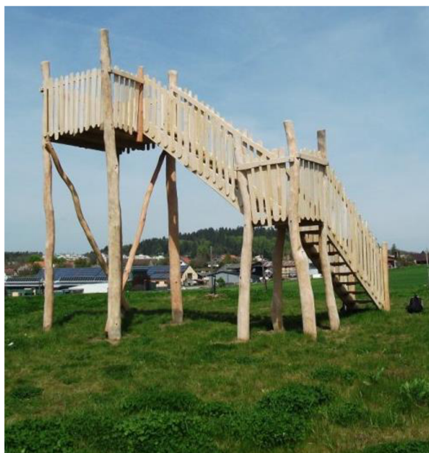
Obrázek 7: Rozhledna Hradiště v Písku (Rozhledna Hradiště, 2023)
