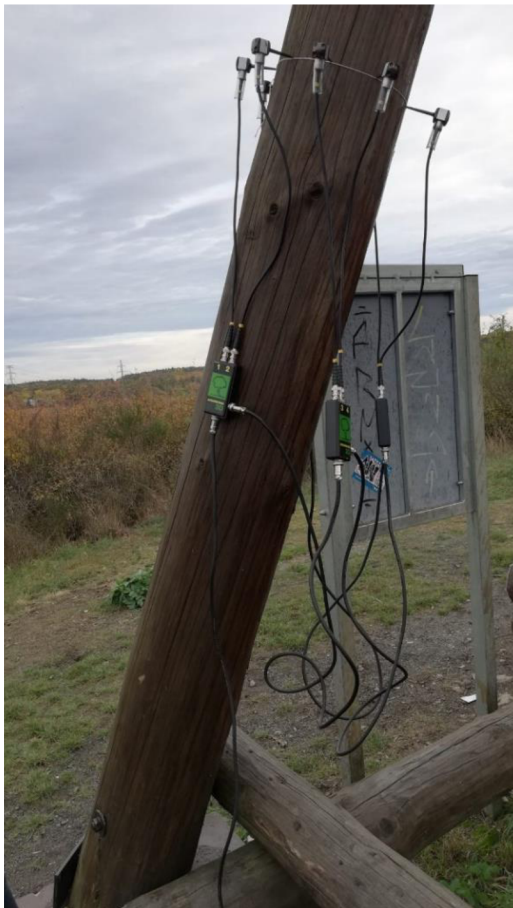
Obrázek 50: Kontrolovaný severovýchodní trám (Zdroj: Autor práce)
