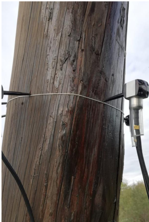
Obrázek 47: Poškození nátěrového filmu na prvku rozhledny (Zdroj: Autor práce)
