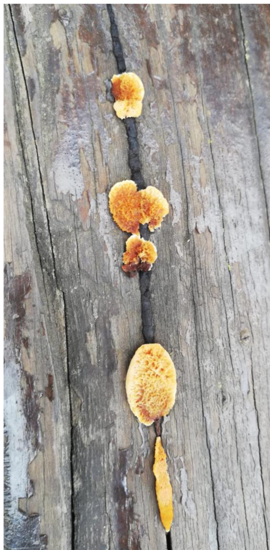
Obrázek 43: Trámovka plotní na prvku rozhledny (Zdroj: Autor rozhledny)
