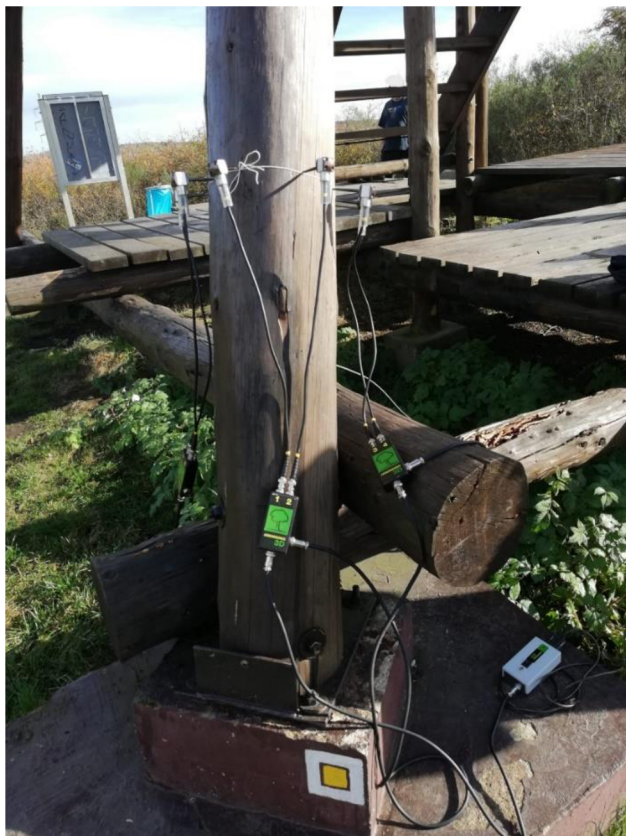
Obrázek 52: Kontrolovaný severozápadní trám (Zdroj: Autor práce)
