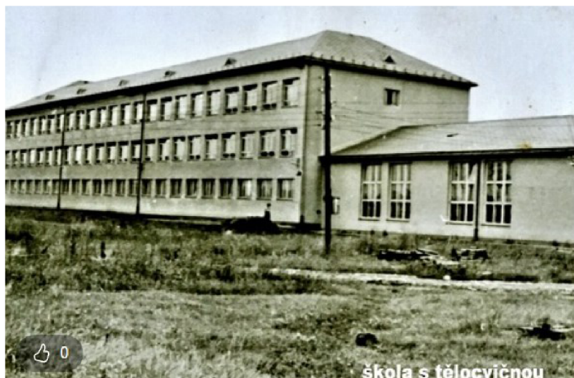
Obr. 1: Historická fotografie školy s tělocvičnou (Historická fotografie školy)
