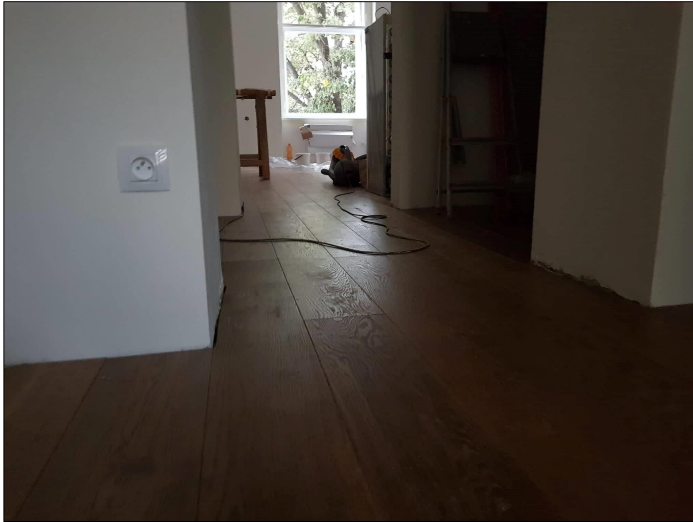
Montáž podlahy a oken
