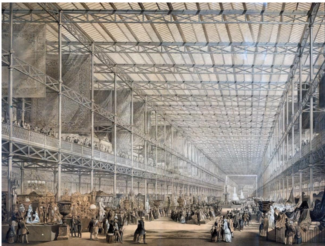
Obr. 2.: Expo 1851 v Londýně – interiér Křišťálového paláce. (Autor: neznámý)
