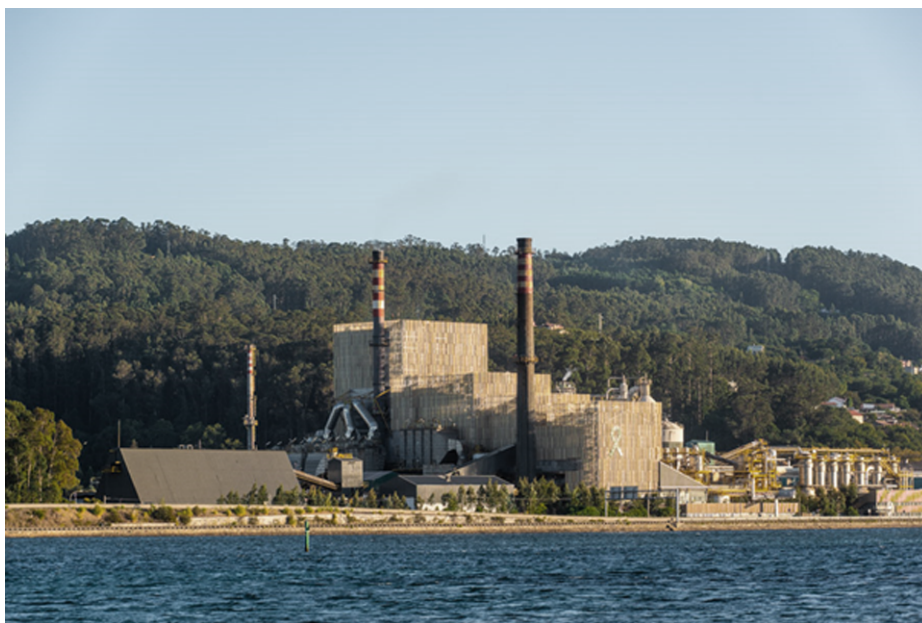
Obr. 39.: Současná fotografie továrních budov. (Foto: Bart Cardinaal)
