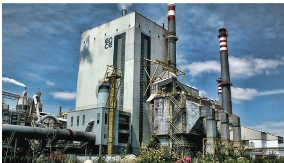
Obr. 40.: Současná fotografie továrních budov (2). (Foto: Bart Cardinaal)
