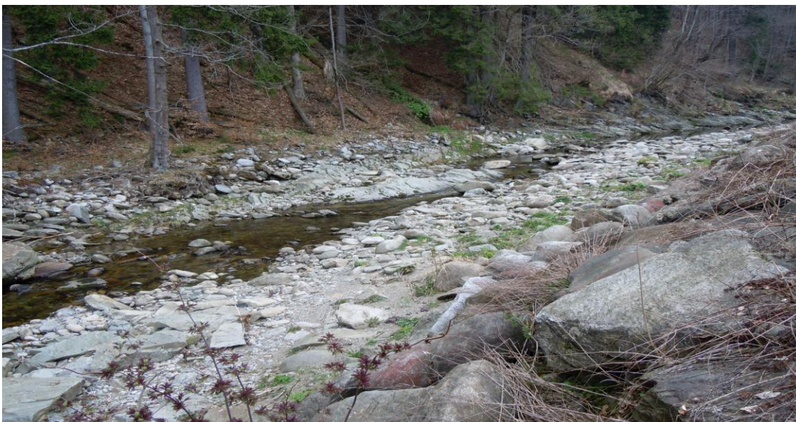
Foto. č.5 Lokalita Nad elektrárnou.
