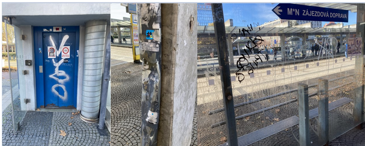
Obrázek 48: Poničené vybavení přednádražního prostoru
