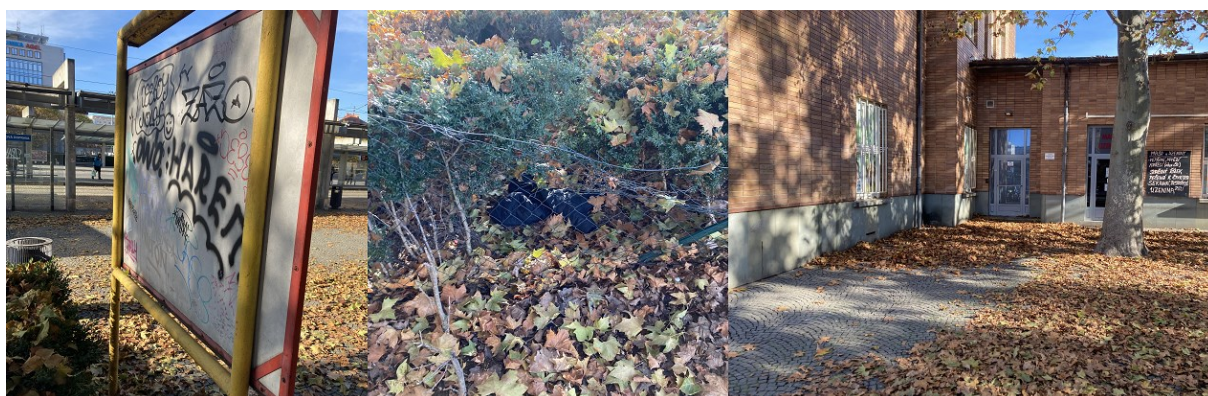
Obrázek 49: Méně využívané prostory před jižní budovou hlavního nádraží
