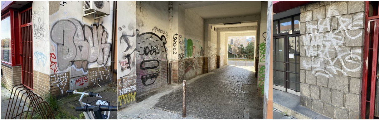
Obrázek 46: Přízemí domu Masarykova 56 a podchod jím procházející
