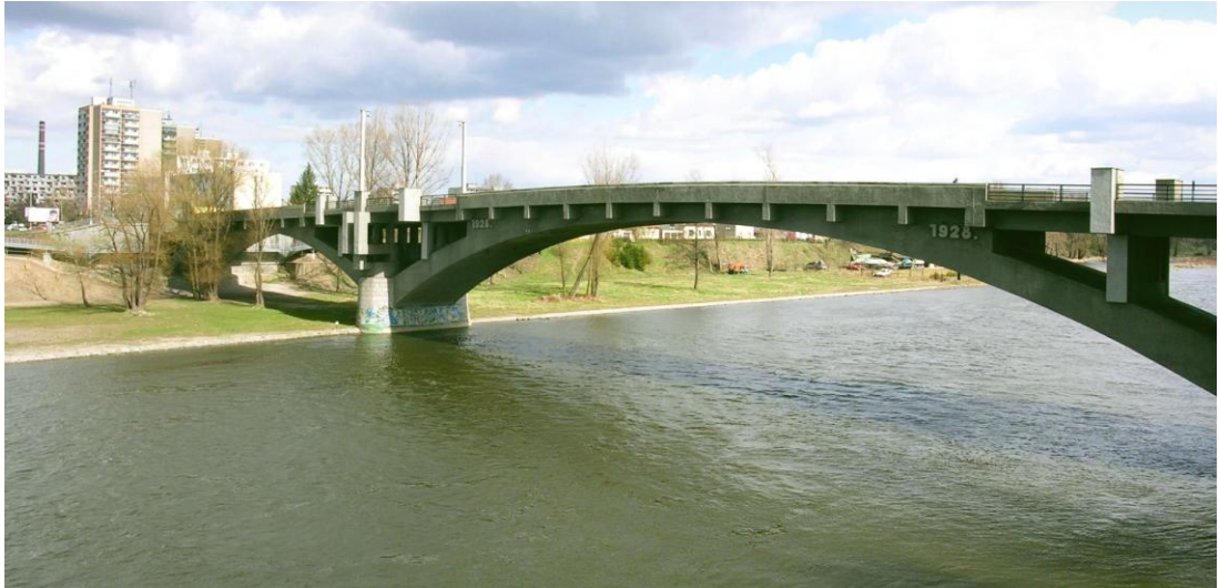
obr. č. 6 Jediný silniční most spojující levý a pravý břeh Vltavy v Kralupech nad Vltavou
