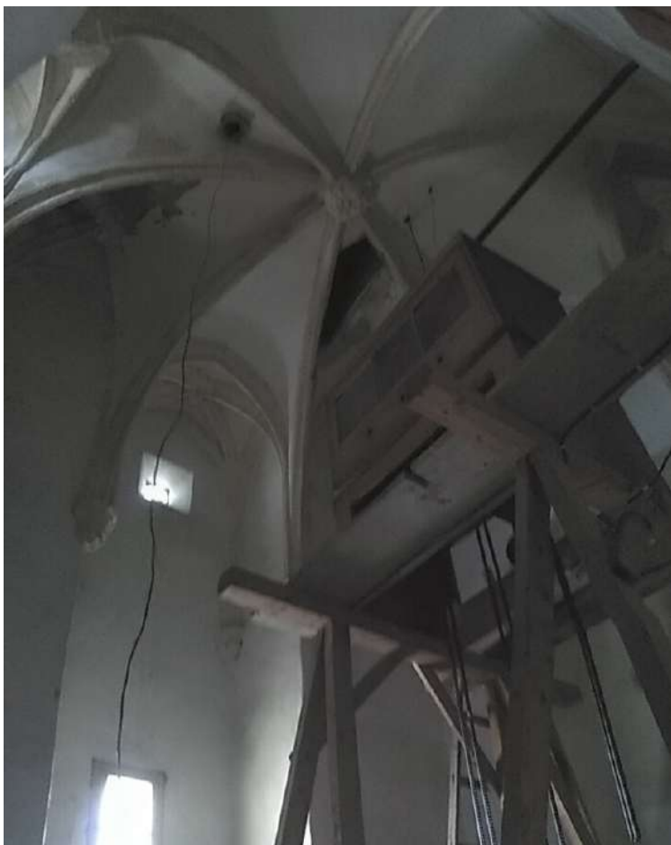
Loděnice, kostel sv. Markéty, druhé patro jižní věže – klenba, 1. čtvrtina 15. století.
