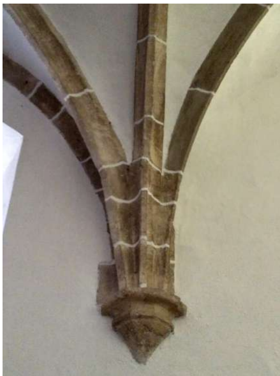
Loděnice, kostel sv. Markéty, jižní boční loď, klenební konzoly, kolem poloviny 15. století.
