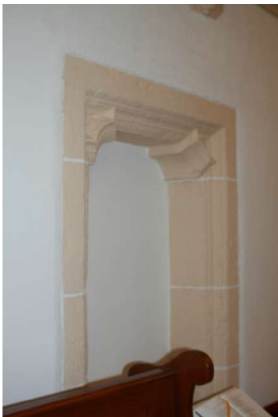
Loděnice, kostel sv. Markéty, presbytář – jižní stěna, zalděný portál do točitého schodiště, 1. čtvrtina 15. století.
