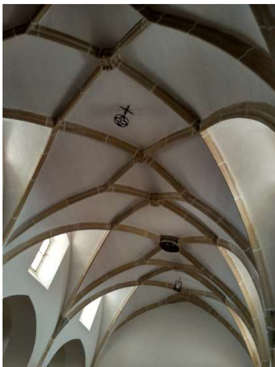
Loděnice, kostel sv. Markéty, hlavní loď, klenba, 1504.
