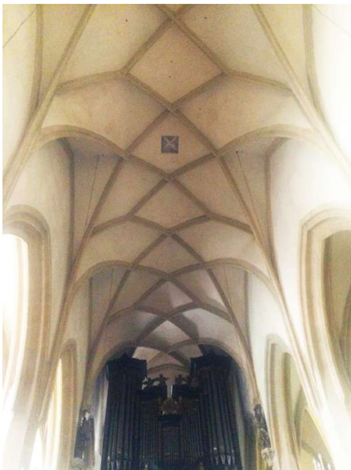
Stein an der Donau, kostel sv. Mikuláše, hlavní loď – klenba, druhá polovina 15. století.
