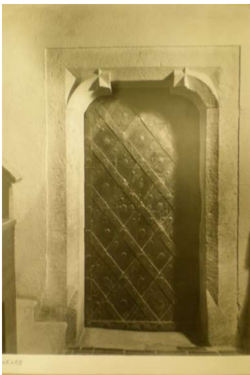
Loděnice, kostel sv. Markéty, portál a kovové dveře do sakristie, konec 15. století (?).
