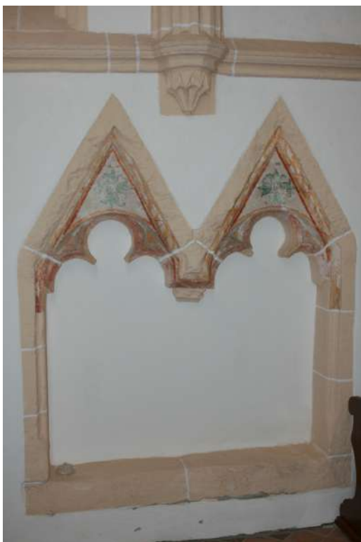
Loděnice, kostel sv. Markéty, presbytář – jižní stěna, sedile, 1. čtvrtina 15. století.
