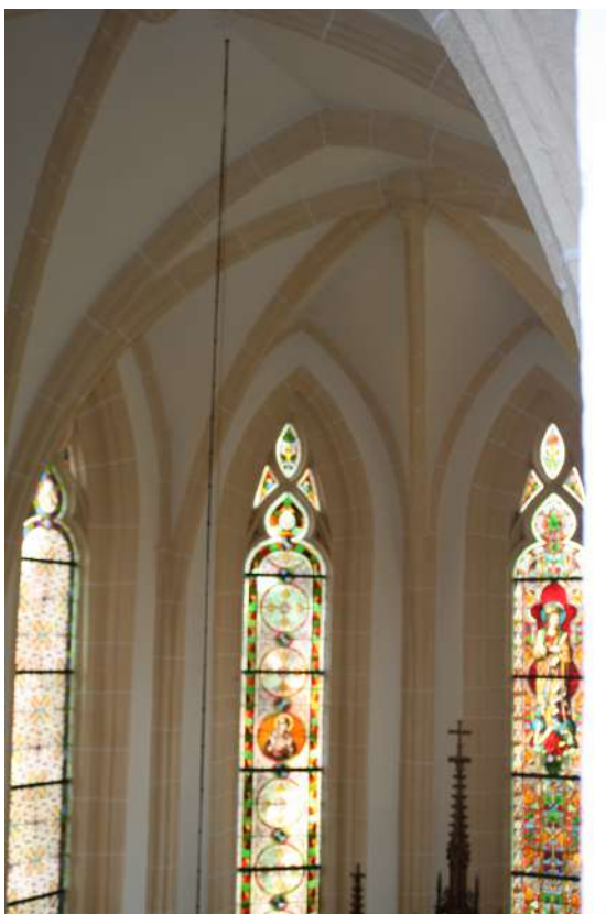
Loděnice, kostel sv. Markéty, presbytář – interiér, 1. čtvrtina 15. století.
