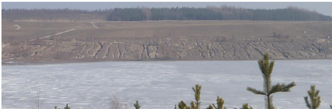
Foto 8: Erozní rýhy v amfiteátru výsypky Lítov - Boden (DLOUHÝ, 2011)
