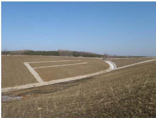
Foto 6: Umělé odvodnění (DLOUHÝ, 2011)
