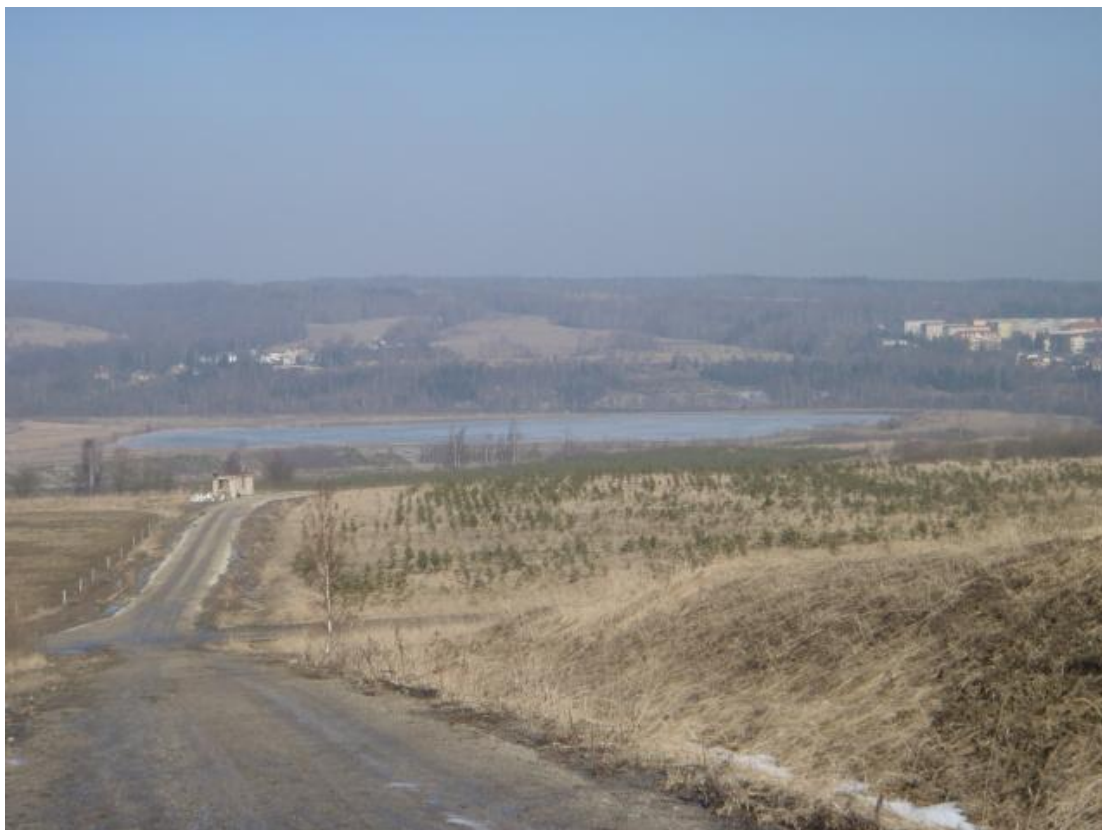
Foto 4: Vodní a lesní rekultivace na výsypce Lítov - Boden: jezero Boden (DLOUHÝ, 2011)
