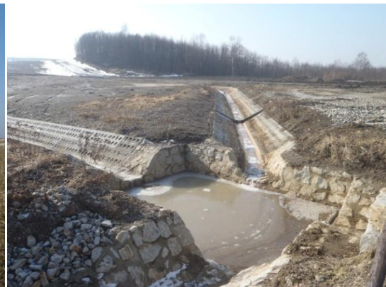
Foto 7: Umělé odvodnění (DLOUHÝ, 2011)
