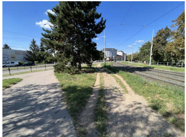
Obrázek 5 - Vyšlapaná cesta podél TT, ul. Bubeníčková [zdroj: vlastní foto]
