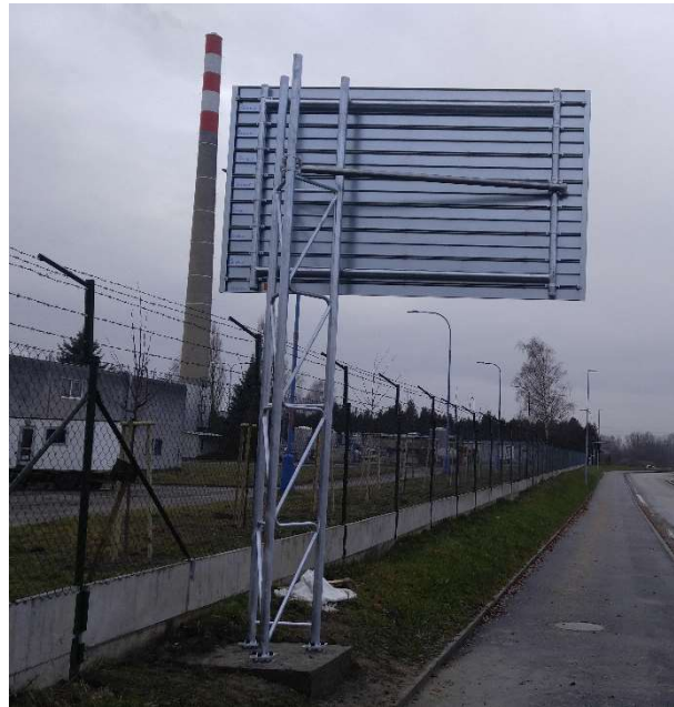
Obr. 10: Nový typ příhradového nosníku – atypické použití, zdroj: [20]
