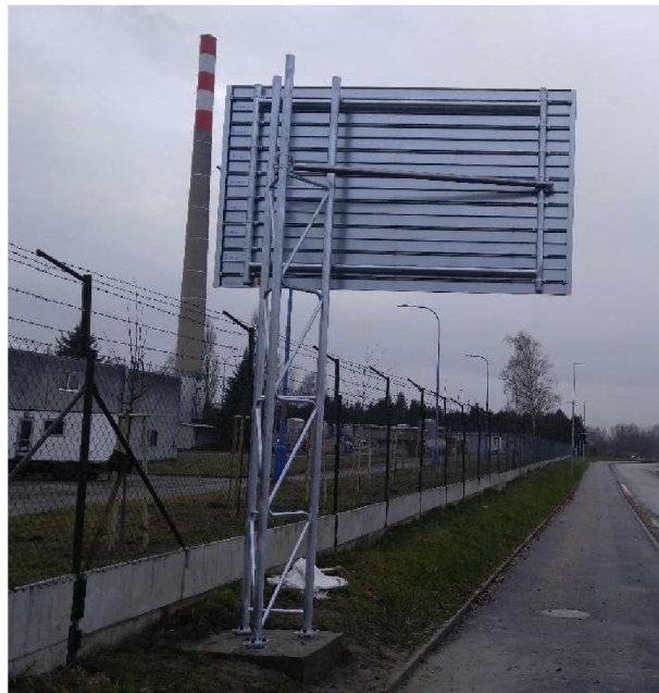
Obr. 10: Nový typ příhradového nosníku – atypické použití, zdroj: [20]
