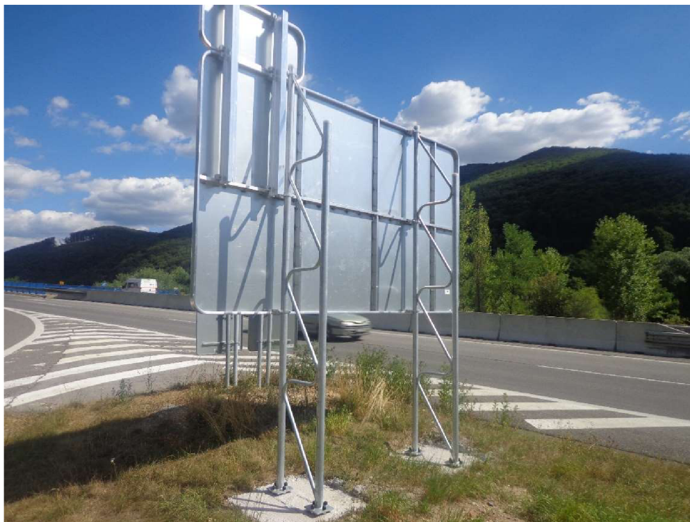
Obr. 8: Stávající typ příhradového nosníku v terénu, zdroj: [20]
