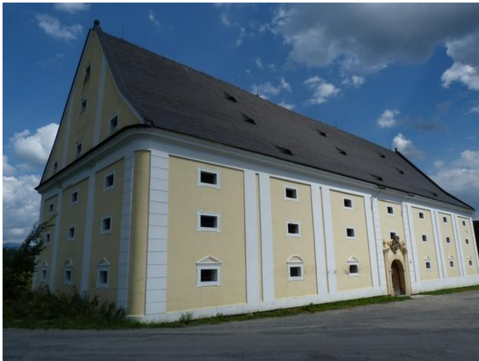
10. Neznámý autor, sýpka, 1729-1730, Velké Losiny, směr Žárová, jižní průčelí
