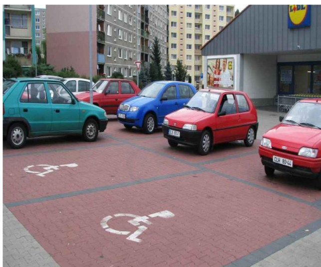
Obrázek č. 4: špatně označené vyhrazené stání, chybí svislé označení [16].
