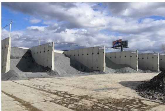
Obr. 23: Skladovací boxy betonového recyklátu D&Z spol. s r.o. (vlastní foto).
