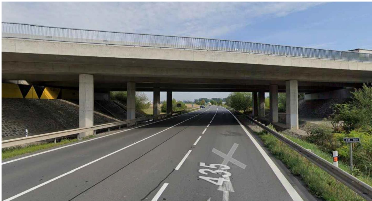
Obrázek 5 Podjezd na komunikaci 435 [1]
