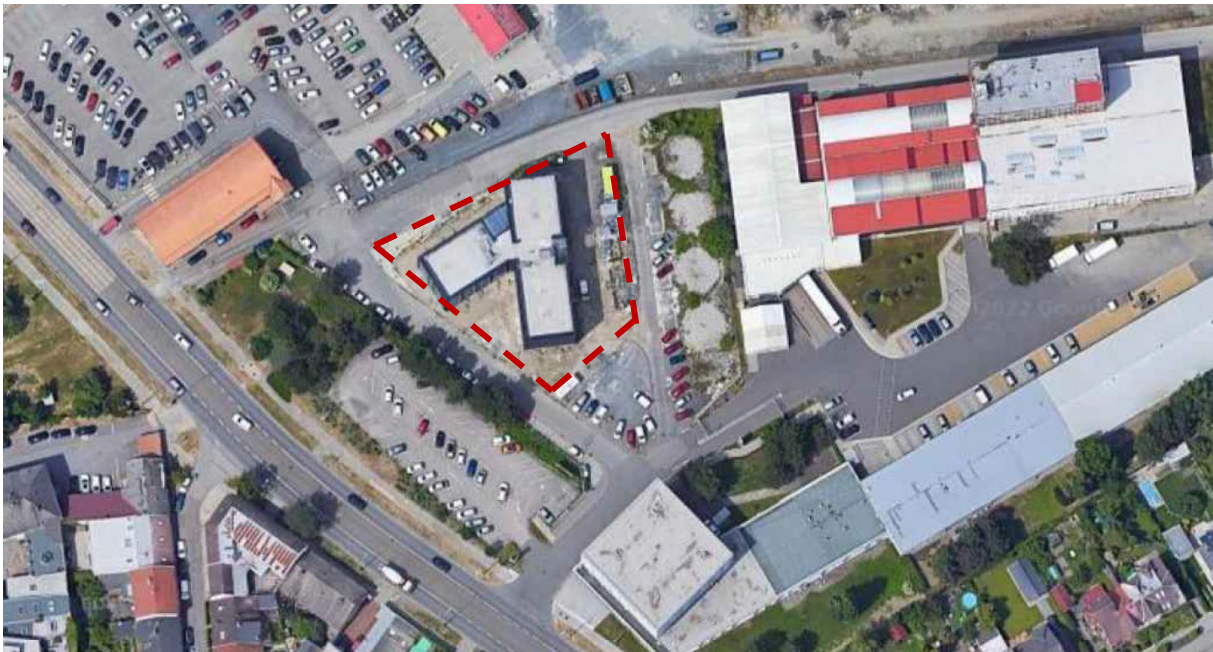
Obrázek 1 Zobrazení staveniště (upraveno autorem) [1]
