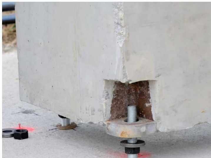
Obrázek 34 Kotvení sloupu [35]
