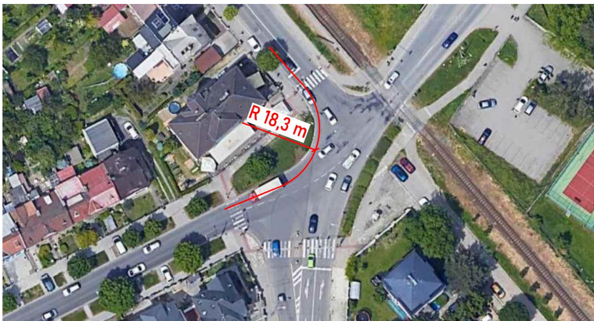
Obrázek 19 Křižovatka ulic Na trati a Erenburgova (upraveno autorem) [1]
