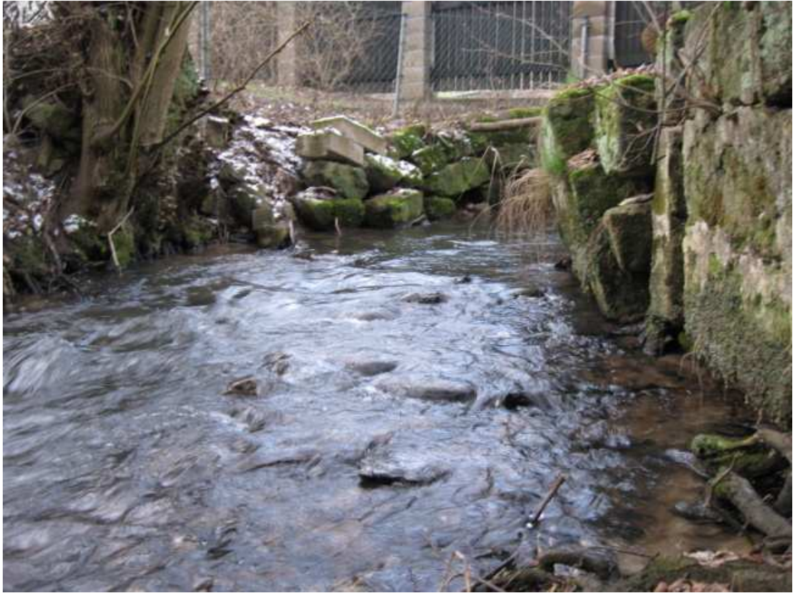
Obr.3 Kamenná rovnanina na toku pod mostkem (foto Váša 2013)
