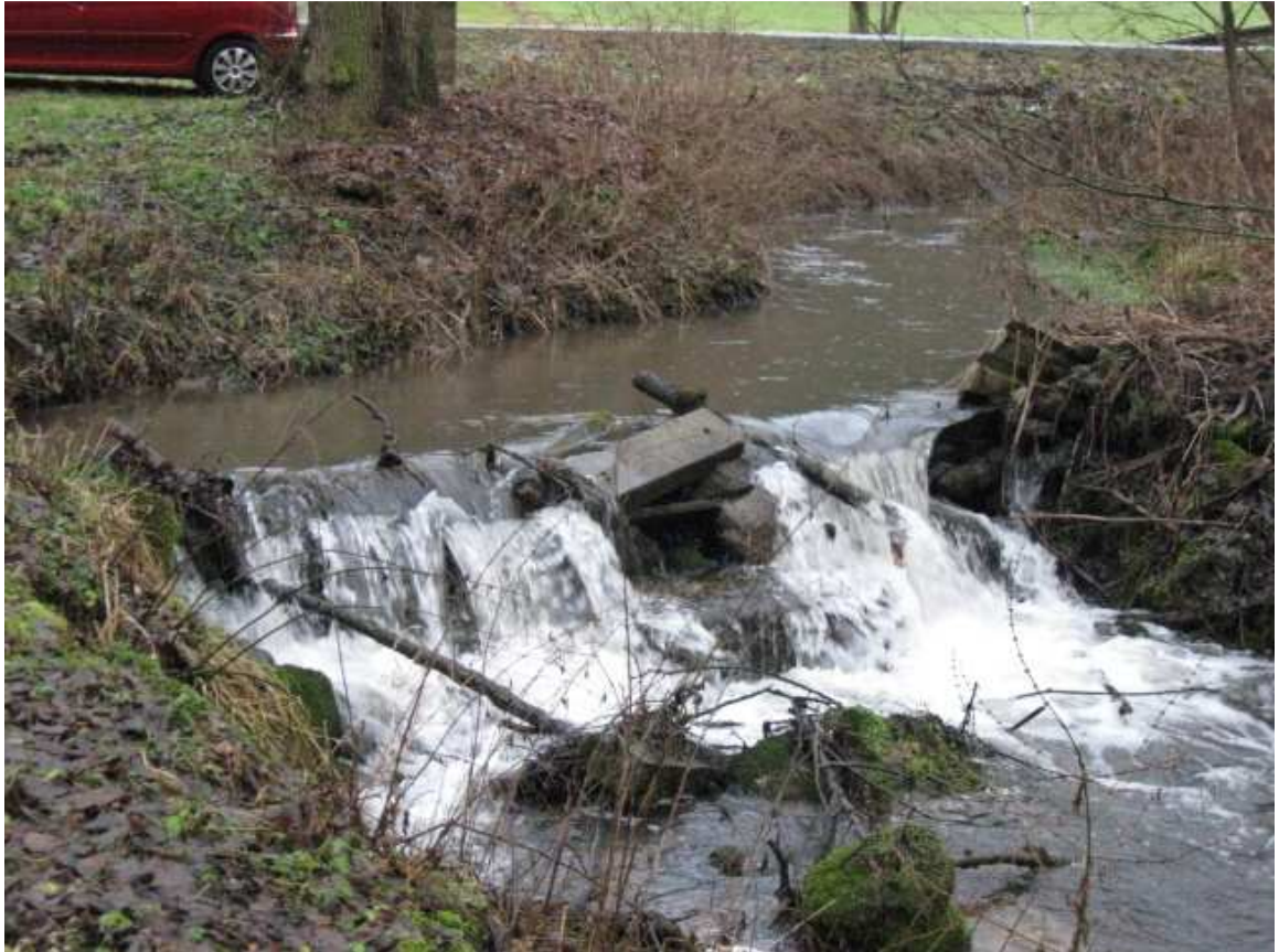
Obr.1 Pohled na polorozbořený jez (foto Váša 2013)
