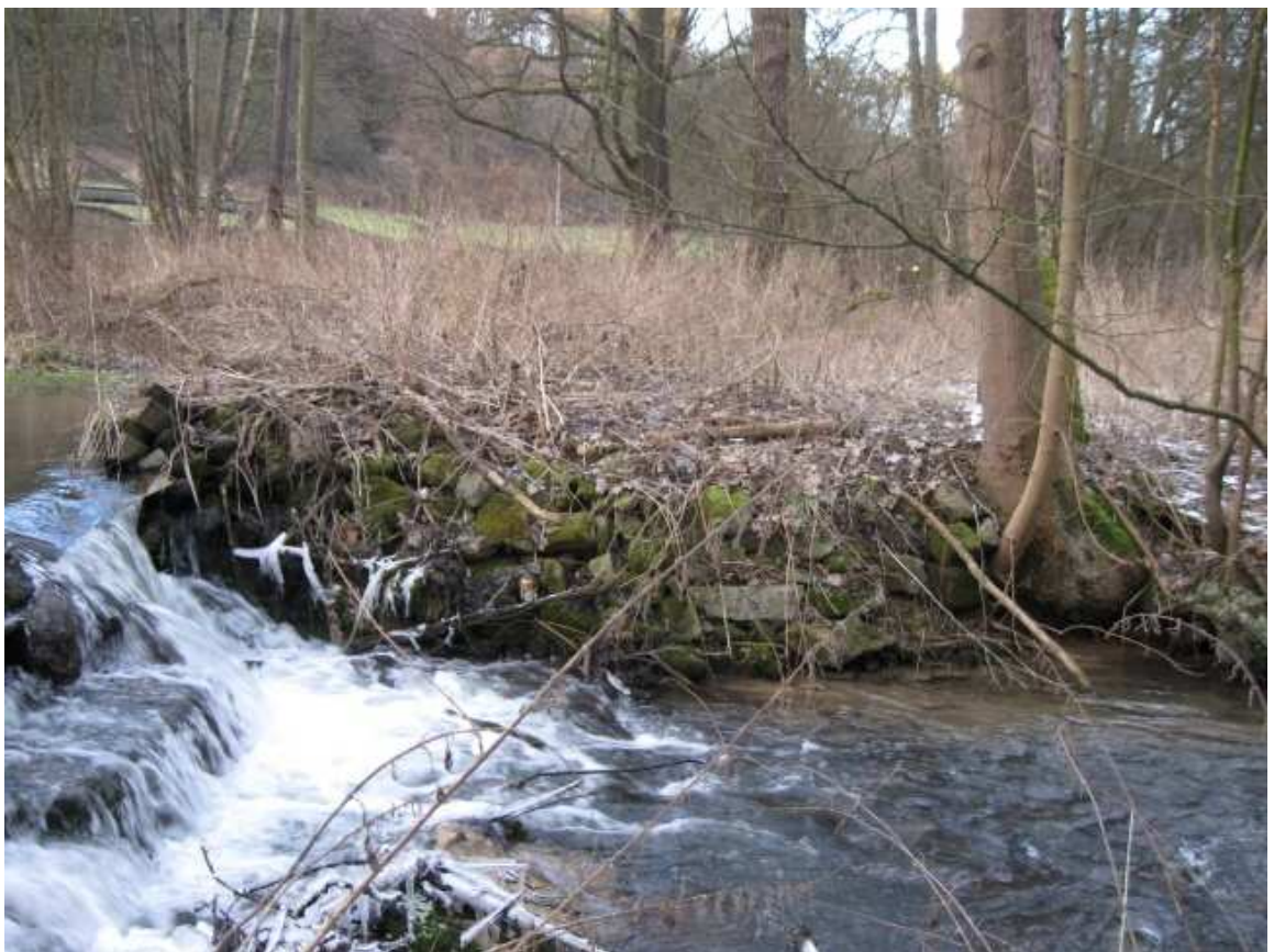
Obr.2 Kamenná rovnánina na pravém břehu (foto Váša 2013)
