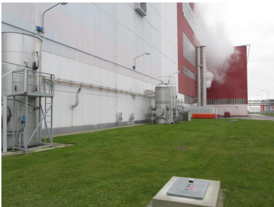
Obrázek 10 Umístění armatur na západní straně obestavby
