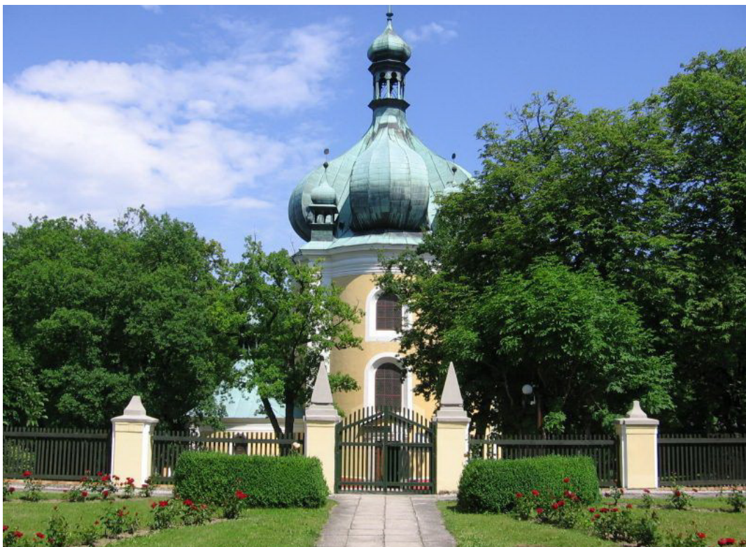
Obrázek 15: Poutní kostel Jména Panny Marie Lomec
