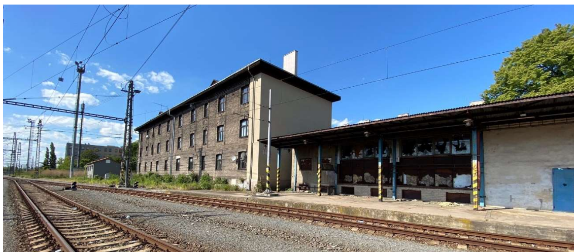
Obr. 14: Jeden z obytných domů na Husově ulici. Pohled od železnice. Zdroj: vlastní archiv autora (viz Příloha 4).
