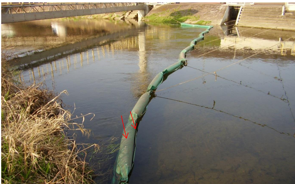
Obr. 10: norná stěna za výpustí ČOV Třinec, šipky ukazující místo, odkud byly nánosy odebírány, upraveno
