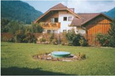
Obr. 10: Venkovní podzemní zásobník pro vytápění domu. (Zdroj: http://hestia.energetika.cz/encyklopedie/6.htm )
