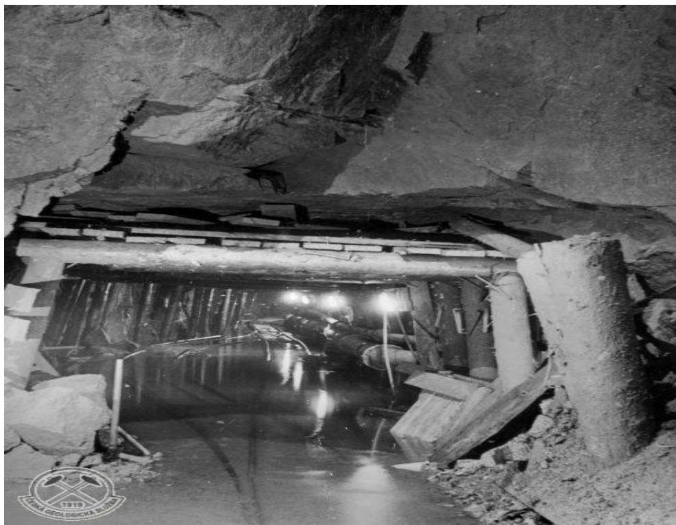
Příloha č. 6 – Foto ražení hlavní šachty (POH, 1960)
