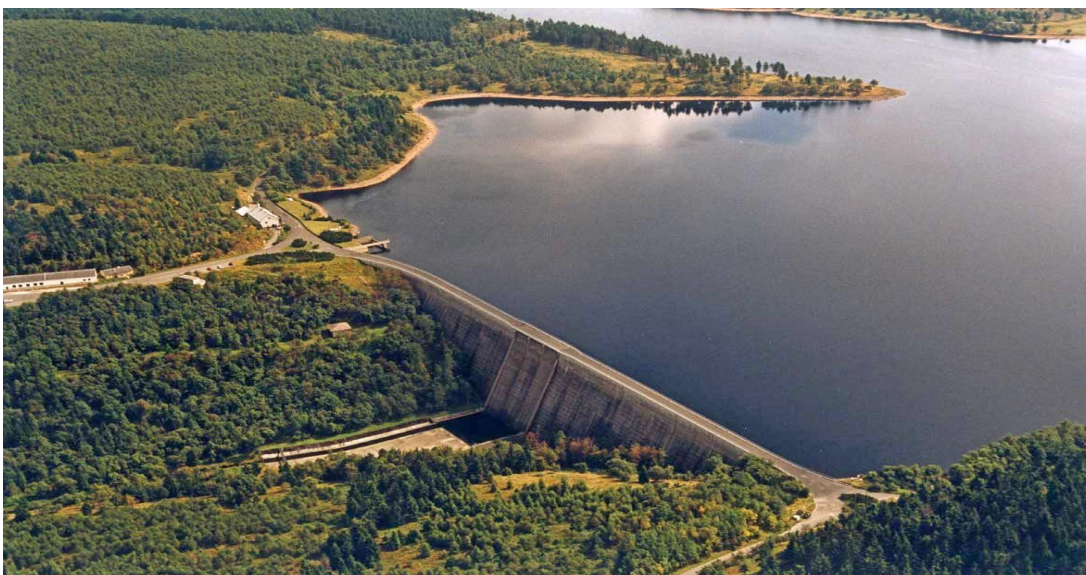
foto č. 1, Letecký pohled na vodní dílo Fláje – těleso hráze (foto: vlastní, 09/2013)
