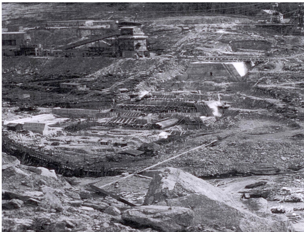
Příloha č.3 – Foto výstavby tělesa hráze (POH, 1951)
