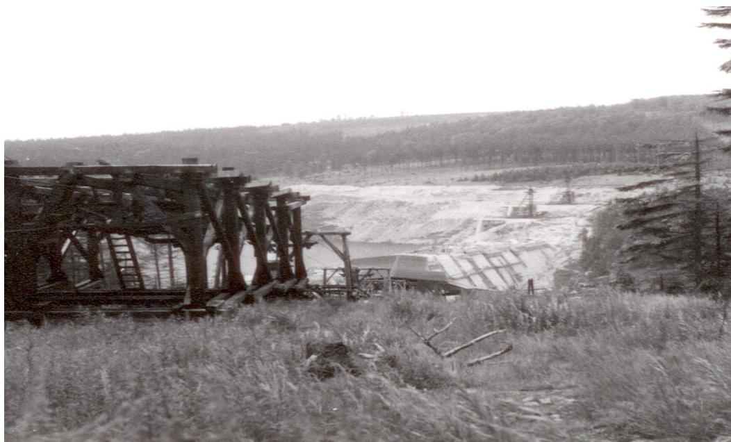
Foto č. 3 – Výstavba lanové dráhy (Povodí Ohře, 1951)
