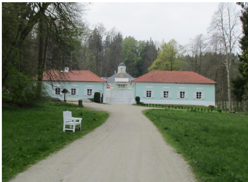
Obr. 1: Fotografie budovy Lázníček dnes využívaných jako prostory pro restauraci a ubytování pro turisty- pohled zepředu (Autor fotografie: Michaela Kühn)
