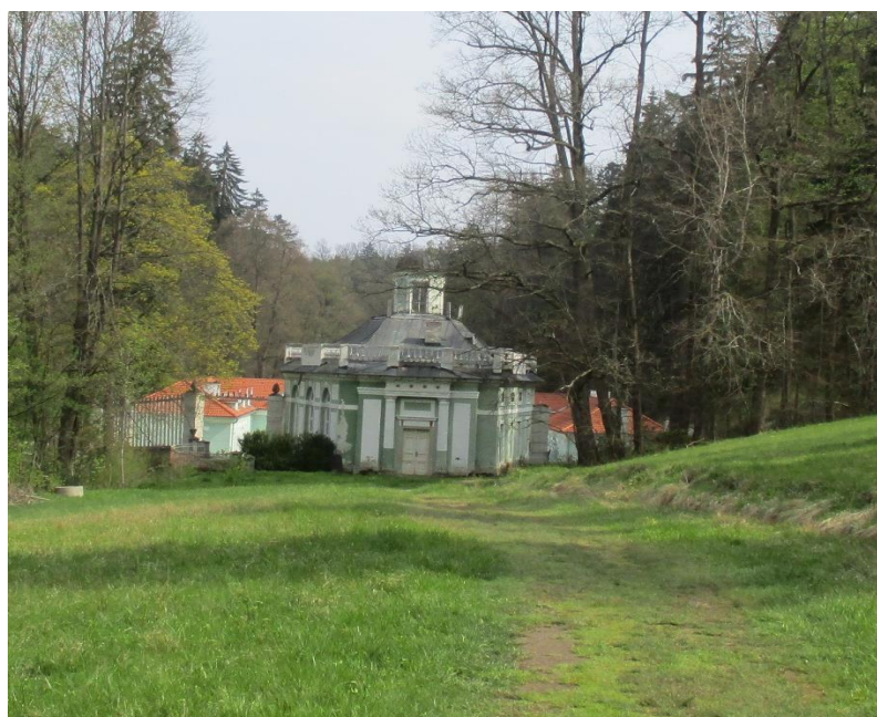
Obr. 2: Fotografie budovy Lázníček- pohled na zadní trakt budovy- foceno z louky nad Lázníčkami (Autor fotografie: Michaela Kühn)
