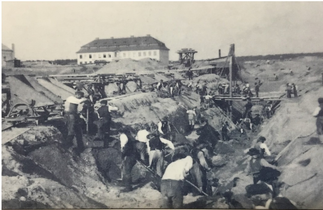
Obr. 2. Stavba Káranánské vodárny v roce 1911 26
