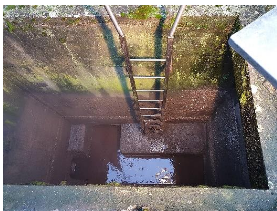
Obrázek 1 - přítok na ČOV
