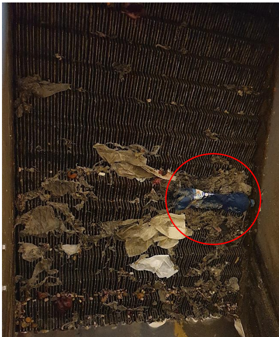
Obrázek 13 - zachycený plastový materiál na jemných česlích ČOV
