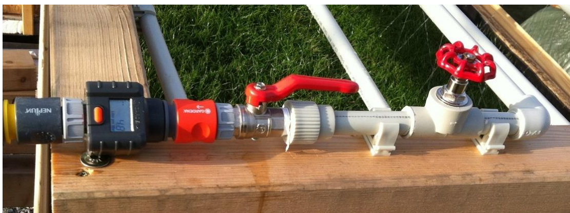
Obr. 5.5 – Zapojení měřicího a regulačního systému zavlažování (autor 26.11.2016).
