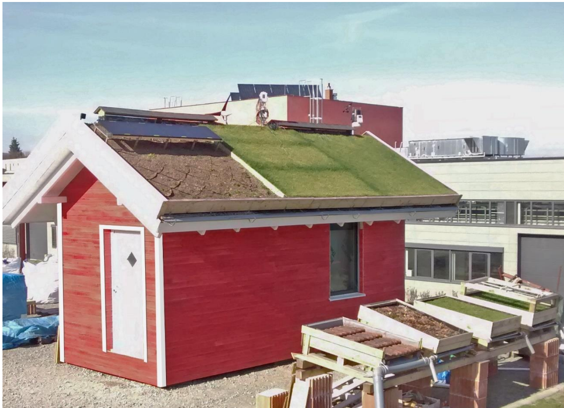
Obr. 5.2 - Západní pohled na experimentální objekt EnviHUT - Brno Admas (Klára Nečadová, 14.3.2016).
