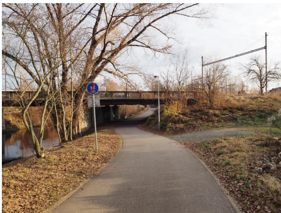
Obr. 6.15 Konec úseku řešeného území - železniční most v blízkosti ulice Vodařská
