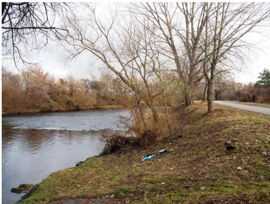
Obr. 6.9 Pohled na břeh Svatky a hráz s cyklostezkou – v blízkosti železničního mostu Poříčí
