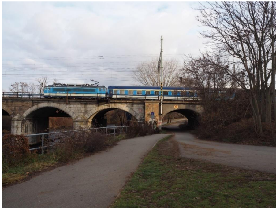
Obr. 6.8 Pohled na začátek úseku řešeného území řeky Svatky – železniční most Poříčí
