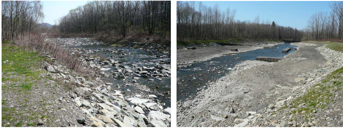
Obr. 8.1 Na levém obrázku protiproudňi pohled na balvanitý skluz, na pravém obrázku poproudňi pohled na spádový stupeň s rozmístěnými výhony z drátokamene (foto Pařílková, duben 2007)
