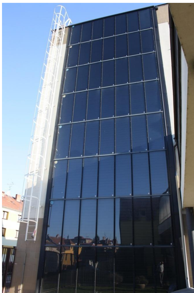
Obr. 24 – Orientace solárních kolektorů na budově [fotografie autor]
