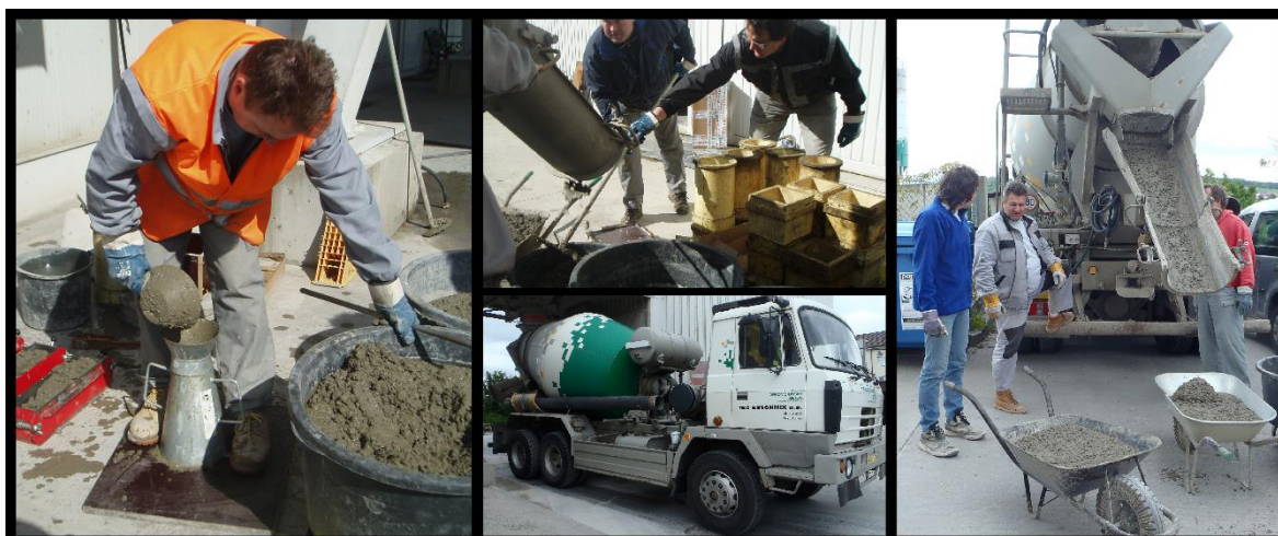
Obr. 14 Výroba čerstvého betonu, zkoušky čerstvého betonu
