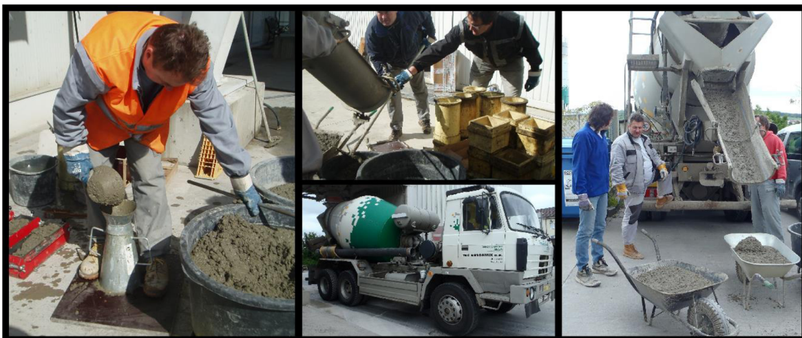
Obr. 14 Výroba čerstvého betonu, zkoušky čerstvého betonu
