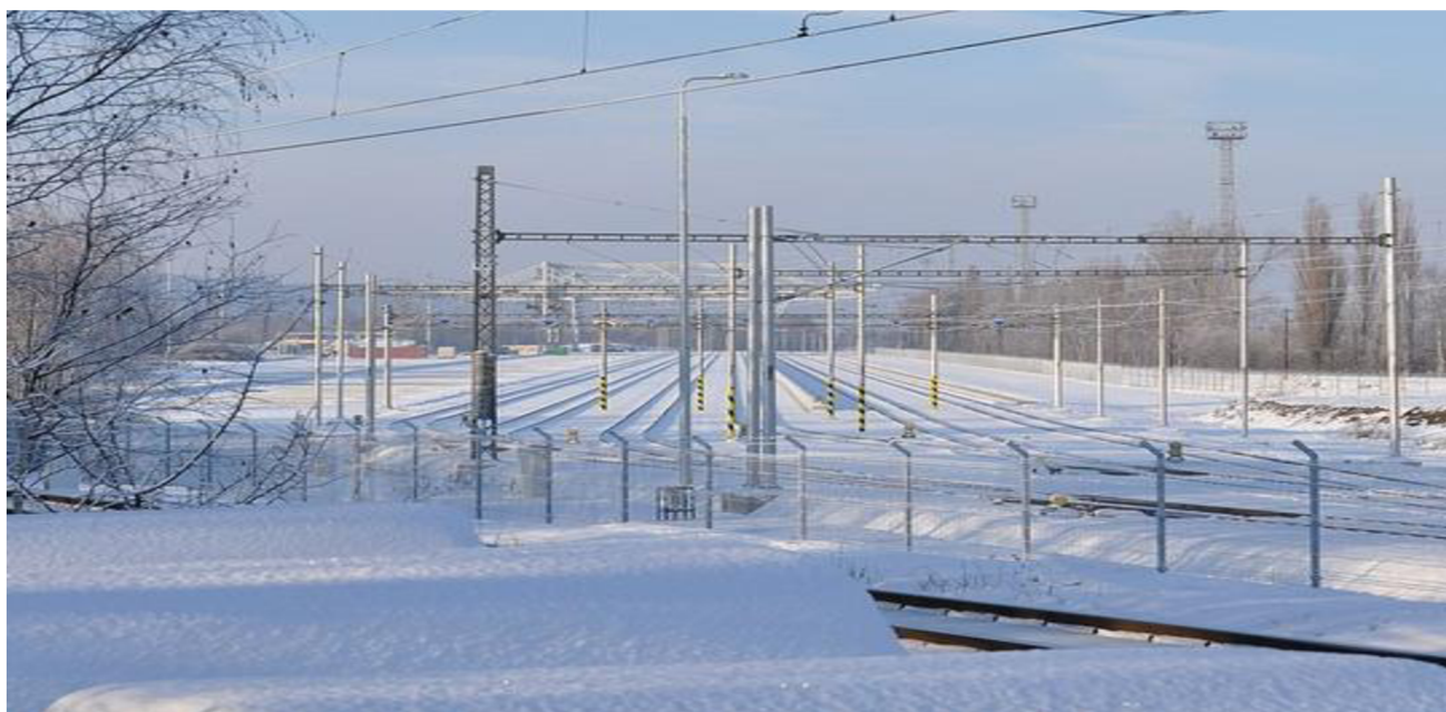
Obrázek 8 - Překladiště společnosti Metrans v České Třebové jenněkolik dní před započatím provozu. [5]
