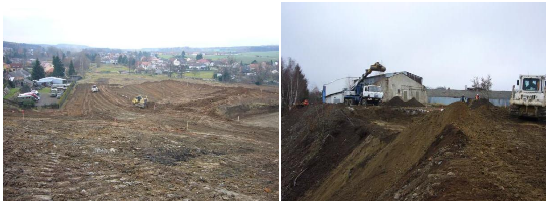
Obrázek č. 8 a 9 Hrubé terénní úpravy v prostoru odvalu a bývalé úpravny - listopad 2012 (bhsanace.správcestavby.cz)
