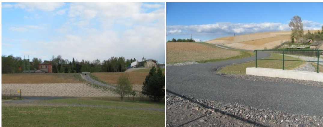
Obrázek č. 10 a 11 Osázené svahy, odvodňovací prvky a vybudované cesty (foto Alena Štíhová)
